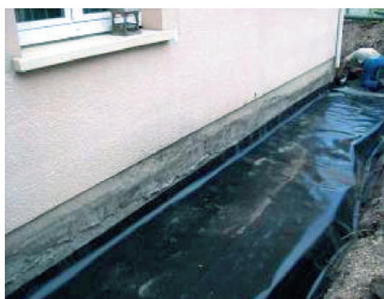
Figure 22 Géomembrane en cours de pose (Source Socabat)
