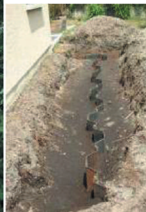
Figure 27 Écran métallique (Source Socabat)
