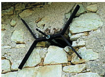
Figure 23 Exemple de chaînage apparent en façade (type croix de St-André) (Source Socabat)
